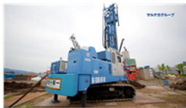
地盤改良工事を支える大型重機
