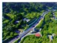
国道349号大綱木工区
