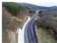
国道114号山木屋工区
